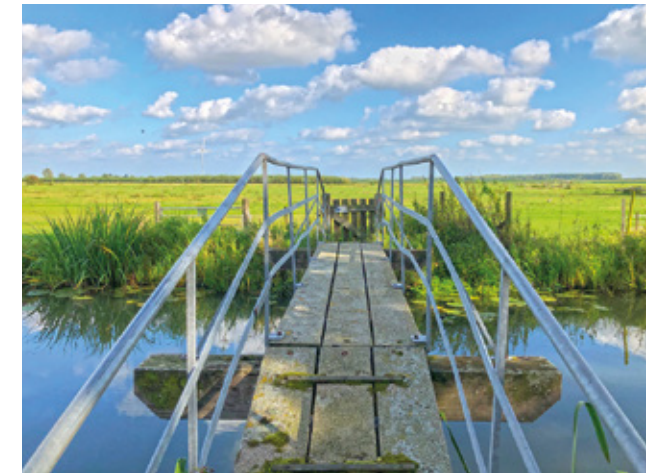
Brug over het water bij Linielanding
